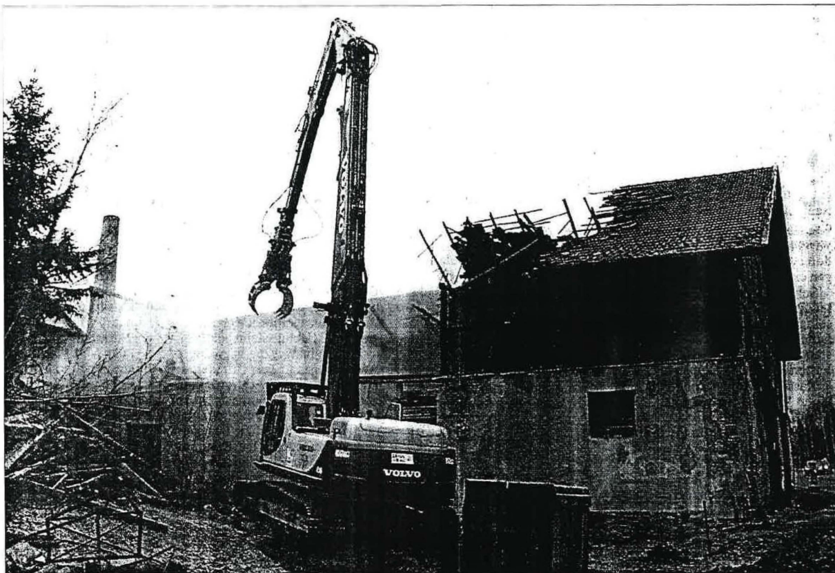
Gestern Vormittag um 11 Uhr: Der schwere Bagger mit einer großen Abbronzange reißt Gebälk und Mauerwerk des ehemaligen Stadels der Lederfabrik, in dem die Rinde für die Grubengärung gelagert wurde, ein. (Fotos: Hackl)
