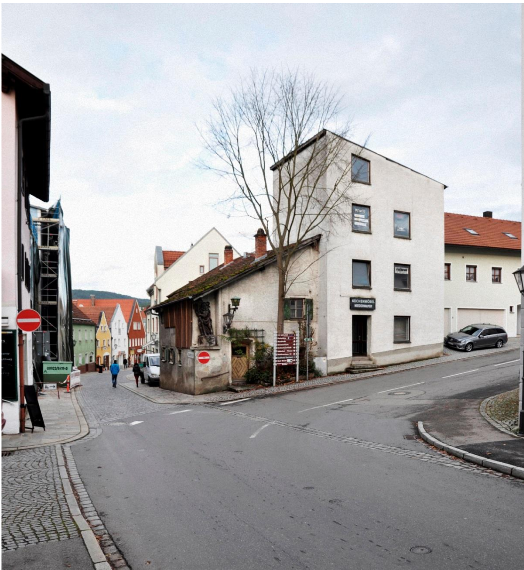
Das Semmler-Haus vor dem Abbruch
